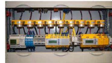
02 Mit den Messstromwandlern und dem RCM lassen sich sicherheitsrelevante Stromkreise permanent auf Fehler-, Differenz- und Betriebsströme sowie vagabundierende Ströme überwachen
