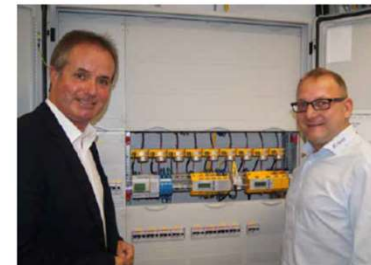
03 T. Püschel mit Peter Eckert, Marktsegmentmanager Datacenter bei Bender, vor dem Schaltschrank mit dem Differenzstromüberwachungssystem
